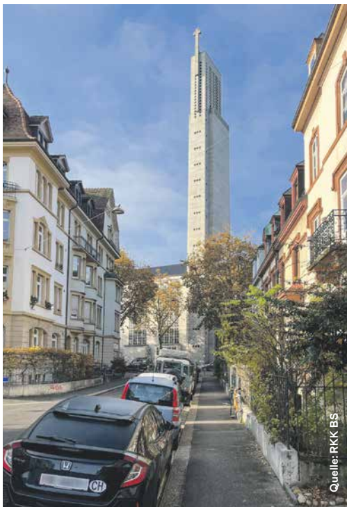
Der Turm der Kirche St. Anton mit einer Visualisierung der Photovoltaikanlage von der Wintergasse aus gesehen
